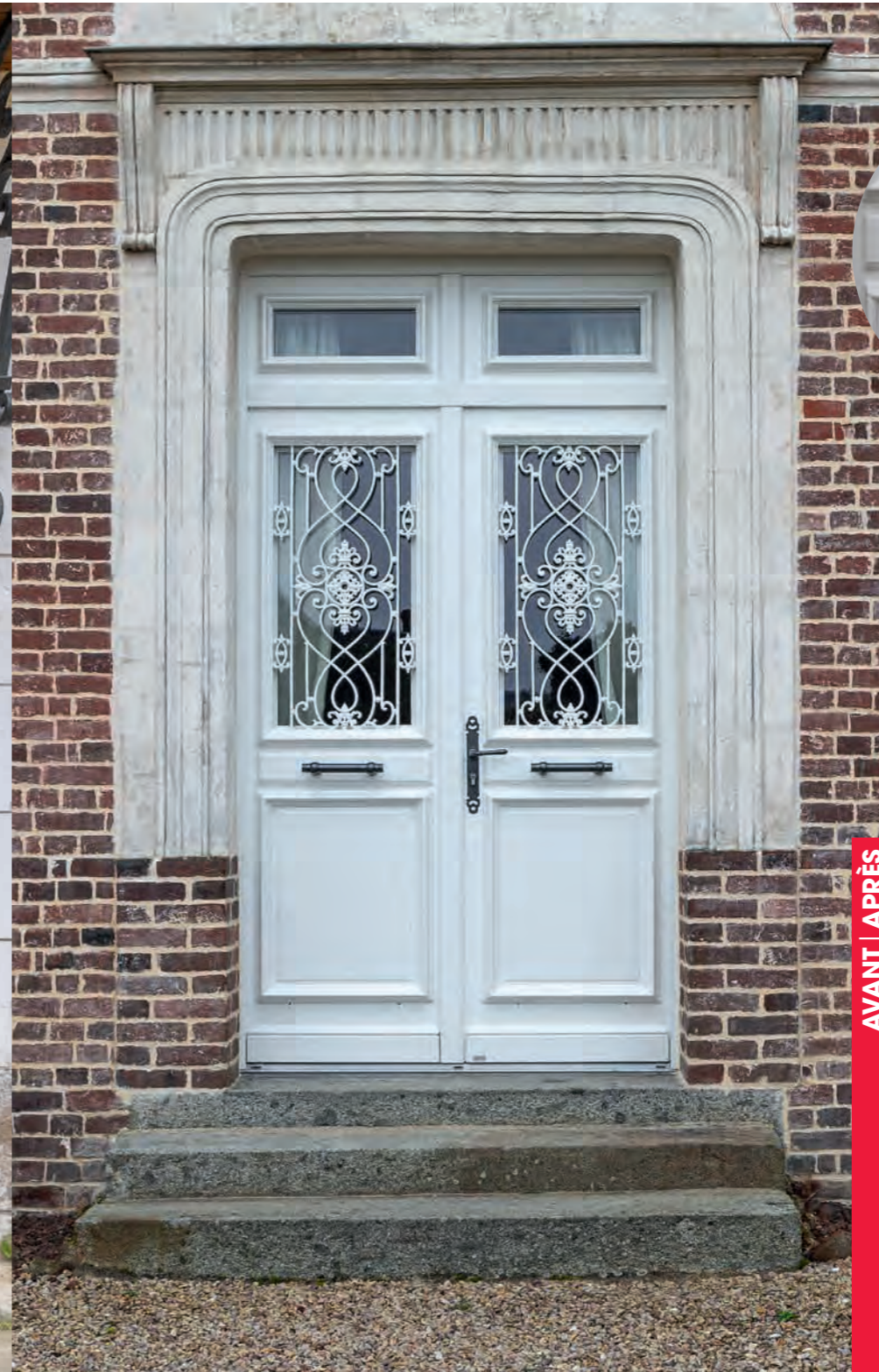
H 2480 : 2050 + 430 imposte / L 1340 : 670 x 2. Blanc 9016 satiné. La porte a été créée à partir d'une photo. Les grilles ont été récupérées. Le client a souhaité ajouter des quincailleries à la finition rustique de notre gamme pour personnaliser sa nouvelle porte.
