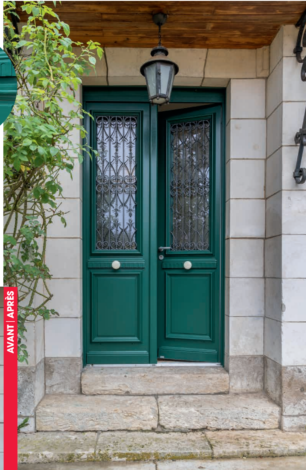
H 2440 / L 1260 : 630 x 2. Vert 6005 satiné. La porte a été créée au plus proche du modèle en place. Pour cela, la grille et les boutons ont été récupérés, les finitions comme la cimaise crénelée et la couleur de la porte se rapprochent de l'existant.
