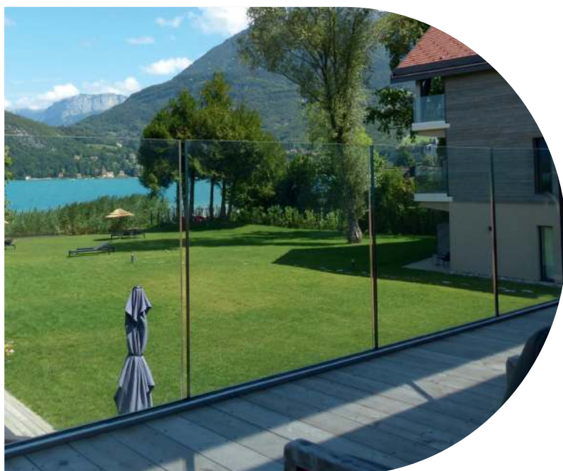
. Pose sur dalle . Vitrage 6.6.4 trempé
