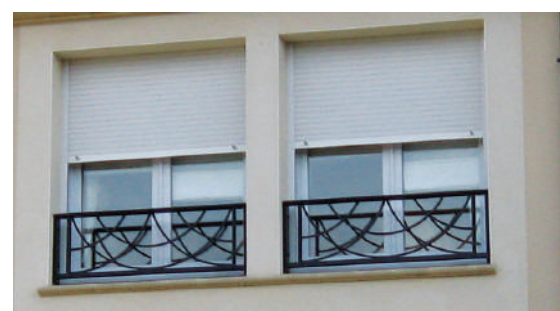
Main courante 50 x 25 mm arrêtes arrondies
