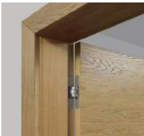
Le **cadre du chambranle contre chambranle** vient habiller le cadre existant. Cette technique permet une rénovation complète avec peu de travaux.
