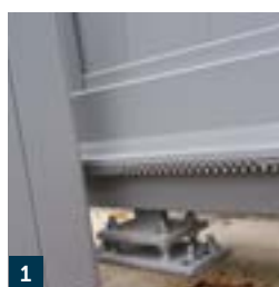
1 - Monture avec galet de guidage.
