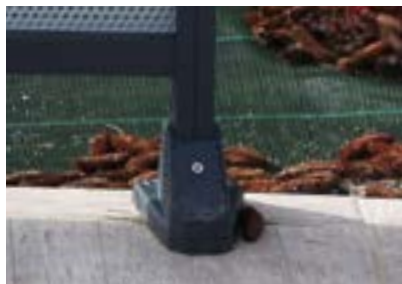
Pose sur dalle ou fixation à la française
