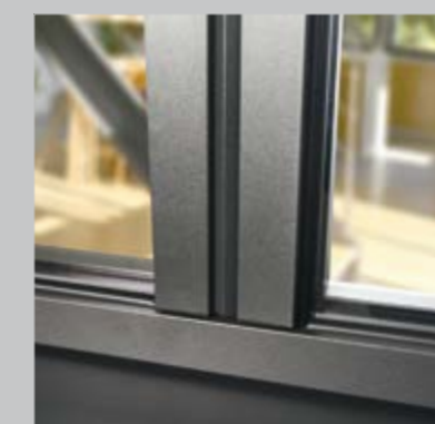
Vue extérieure du battement central
