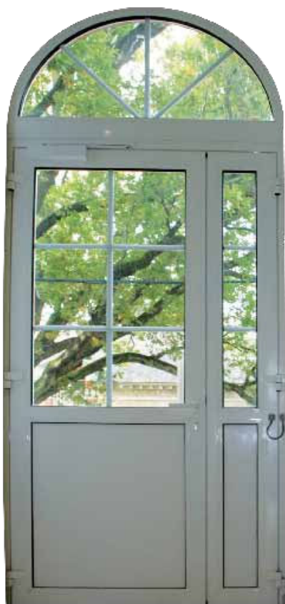
Porte technique 2 vantaux avec imposte fixe
