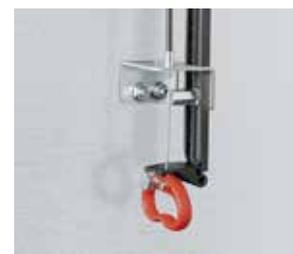
Déverrouillage de secours de la motorisation, positionné à l'intérieur du garage.
